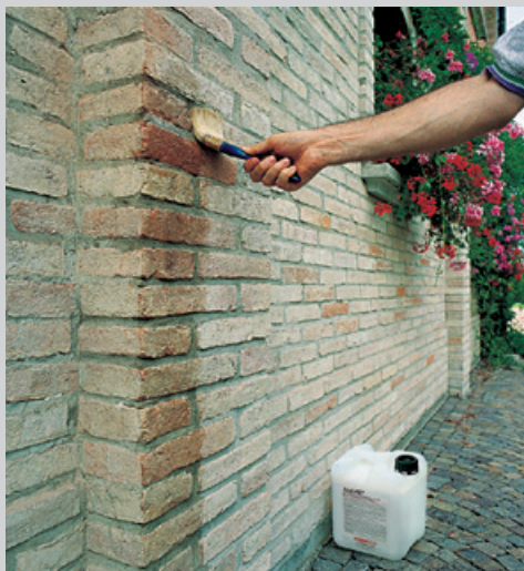
Обработка кирпичной кладки водоотталкивающим составом LITOLAST .
